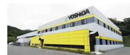
震災後、高台に工場を新設した
