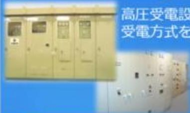
高圧受電設備には信頼性が高く、重要度の高い受電設備に用いるC/B形受電方式を単純化してコストダウンしたPF・S形があります
