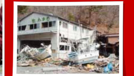
震災直後の第三加工場。外壁の損傷は激しいが奇跡的に屋根が破れずに残った。
