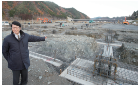
11月末の取材時には基礎工事が行われていた新工場建設現場
