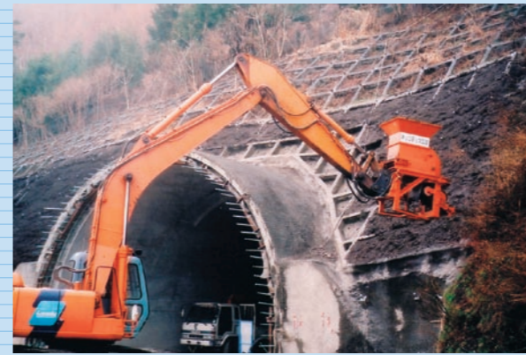
▲法面緑化工事。ネッコチップ工法を進化させ、製造した緑化基盤材を使用
