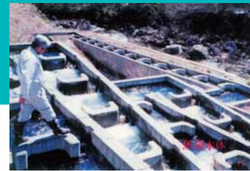
IM式魚道導入後 IM式魚道の導入後の魚道本体での流水は正常となった。また、一年間の追跡調査で、維持管理不要な魚道であることの確認が得られた。
