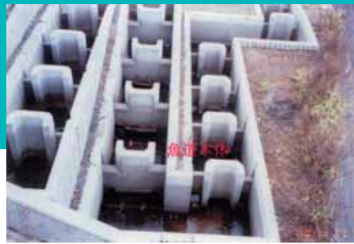
IM式魚道導入前 IM式魚道導入前は魚道本体での流水が認められなかった。
