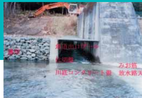
IM式魚道導入後 平成15年11月、魚道機能の正常化を目的に、IM式魚道を導入した。IM式魚道の内容は、仕切盤、魚道出口プール、みお筋、川底コンクリート張、護岸、副堤嵩上げ、等である。
