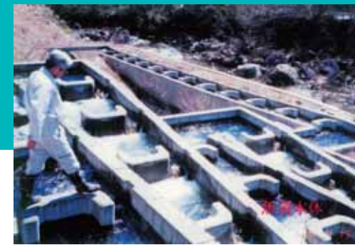
IM式魚道導入後 IM式魚道の導入後の魚道本体での流水は正常となった。また、一年間の追跡調査で、維持管理不要な魚道であることの確認が得られた。
