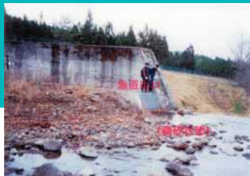
IM式魚道導入前 中ノ又砂防ダム魚道(岩手県水沢地方振興局管内、金ヶ崎町)は、平成11年の開設時から平成15年10月まで、土砂やゴミの影響で、魚道出口が閉塞し魚道機能が不全であった。
