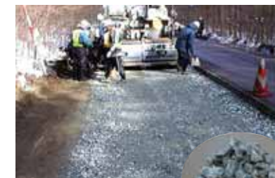
開発路盤材による 工事風景
