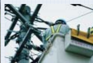
工事に関する確認事項は驚くほど多い。前後に綿密なチェックが行われる。
